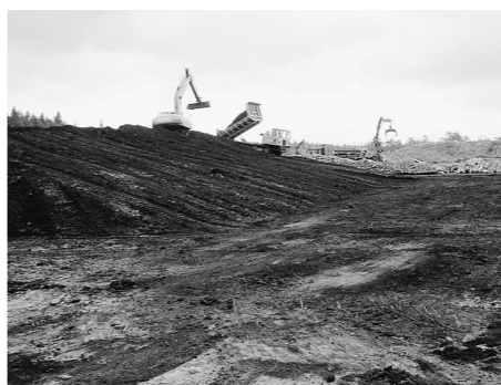
(仮称)北秋田市民病院2次造成工事は工期を12月20日とし、順調に進められています。
