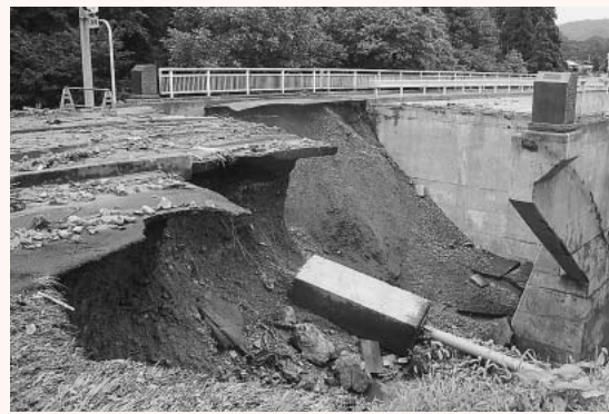
崩落した105号・新荒瀬橋
