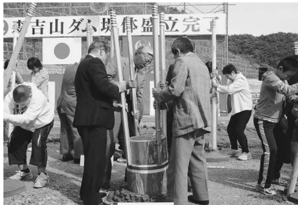
▶古来の「二本搦ぎ」「蛸搦ぎ」などを行い盛立の完了を祝い、23年度の完成に向けさらなる整備促進を願った「森吉山ダム堤体盛立完了式」(10月19日)
