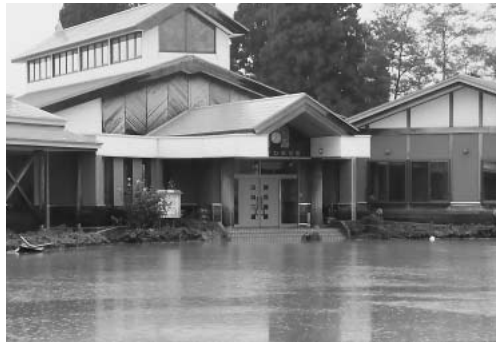
▲床上浸水の被害を受けた合川保育園
