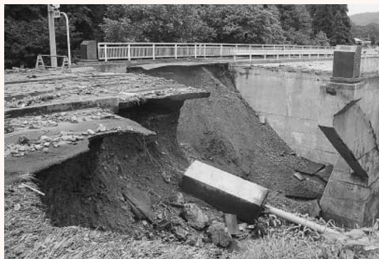
崩落した105号・新荒瀬橋
