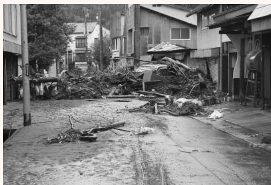
氾濫で街路に残された泥とがれきや流木(前田地区)
