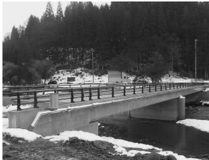
▲3月に完成予定の平里橋
