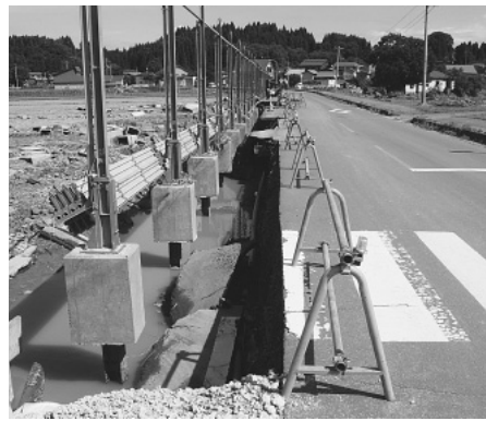
▲復旧工事が行なわれる市道李岱川井線
