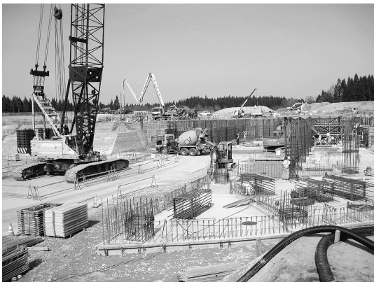
▶基礎及び地階部分の工事が行われている市民病院（4月9日）
