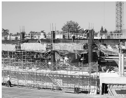
21年8月の竣工に向け順調に工事が進められています
