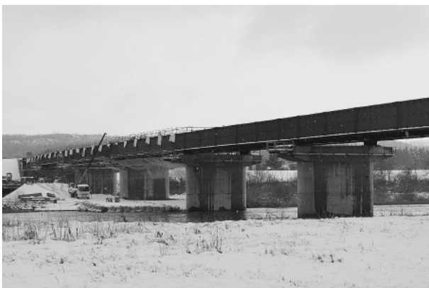
建設中の中岱橋（10月上旬供用開始予定）
