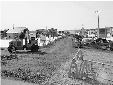
▲本体工事が始まった都市計画道路太田川口線整備事業
