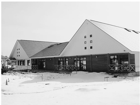
新園舎が完成し、保育環境が充実した南鷹巣保育園
