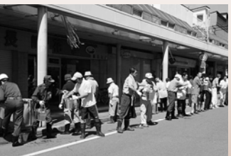
▲ パケツリレーによる初期消火
