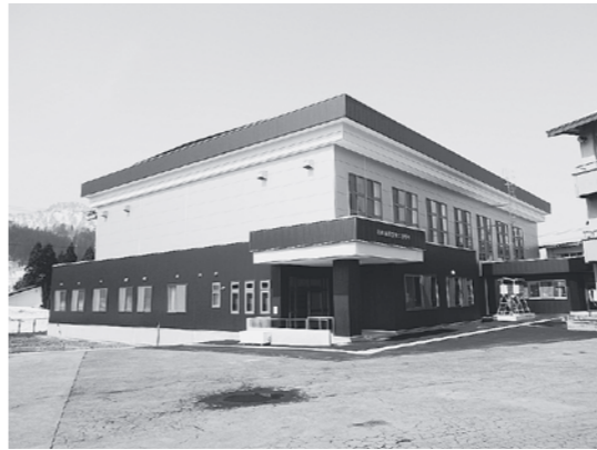
▲完成した鉄骨造平屋建ての新体育館
