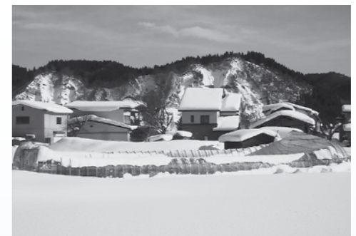
▲ 雪の重みで倒壊したパイプハウス
