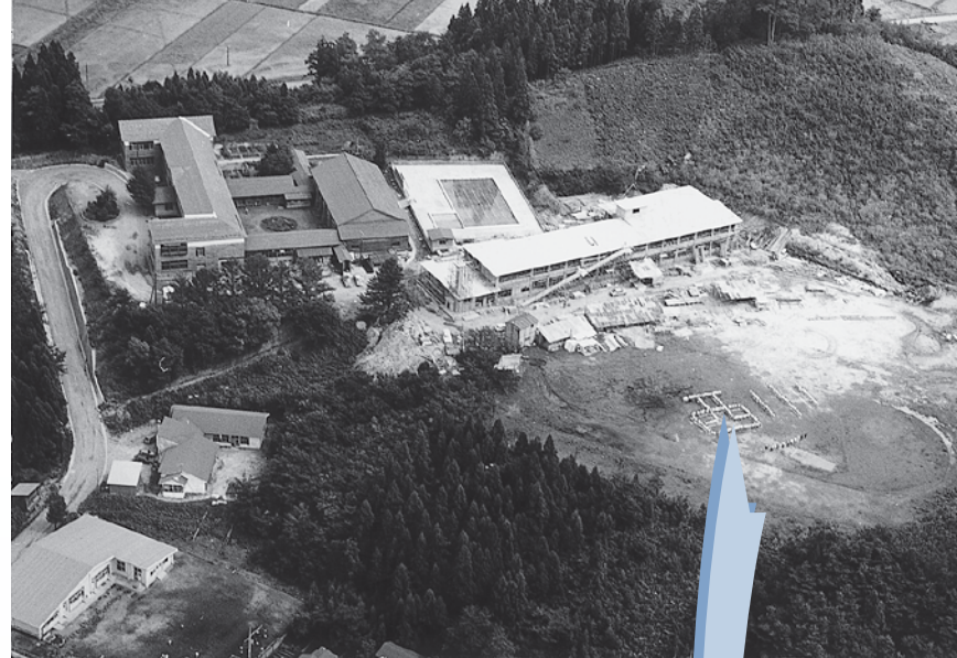
▲いたての森に囲まれた新旧2つの校舎。左奥が旧校舎でその右が建設中の現在の校舎（昭和48年）
