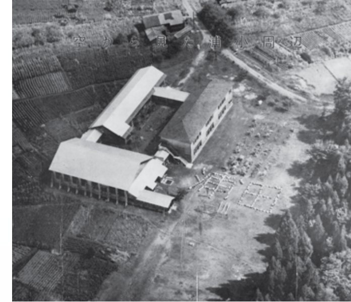
▲木造2階建旧校舎の航空写真 （4代目校舎：昭和27年～平成4年）
