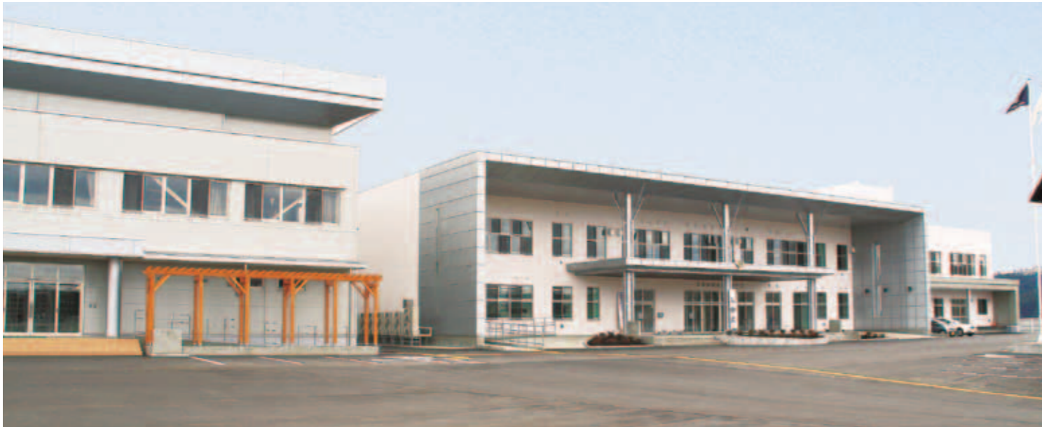
▲完成した合川小学校の校舎と体育館（写真左）
