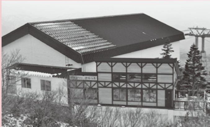
▲山頂駅舎の隣に完成したビジターセンター
