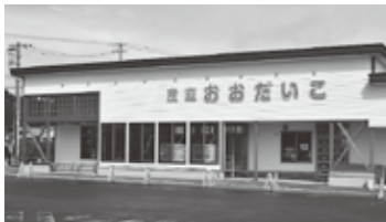
道の駅たかのす内に建設され、今年度オープンする「農産物等直売所」
