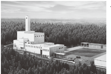
▲平成30年4月の稼働を目指し工事が進むクリーンリサイクルセンターエネルギー回収推進施設（完成予定図）
