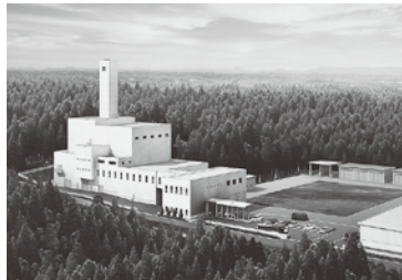
▲平成30年4月の稼働を目指し工事が進むクリーンリサイクルセンターエネルギー回収推進施設(完成予定図)
