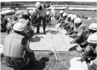
▲秋田県代表として、シート張工法に取り組む市消防団第4分団員
