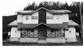
↑移住定住ネットワークセンターを整備
