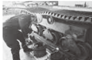
作業状況①
