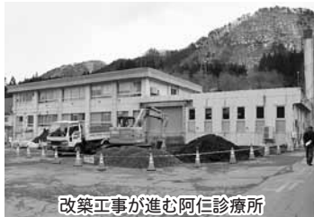
改築工事が進む阿仁診療所
