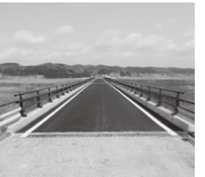
橋りょう補修工事、一部完成した坊沢大橋
