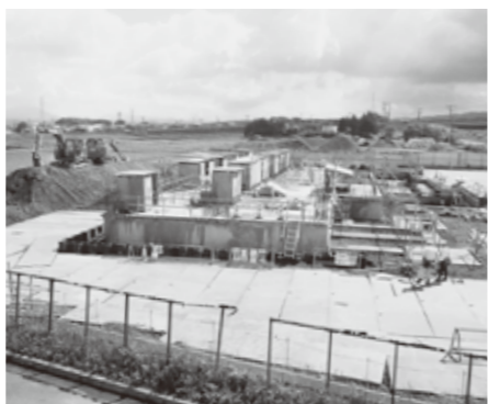
着々と工事が進む、し尿処理施設(5月31日時点)
