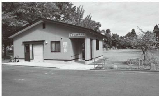
完成した中央公園の休憩施設は、裏手が広場になっており、多目的トイレにはおむつ交換用ベッド、子ども用便座も完備しています。
