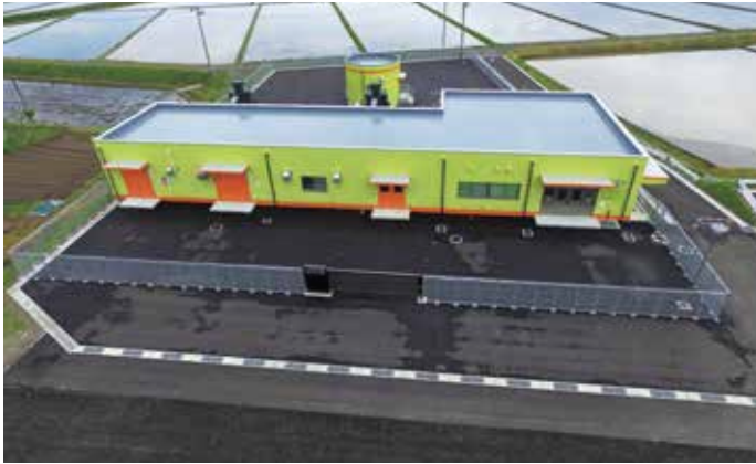
米内沢浄水場
