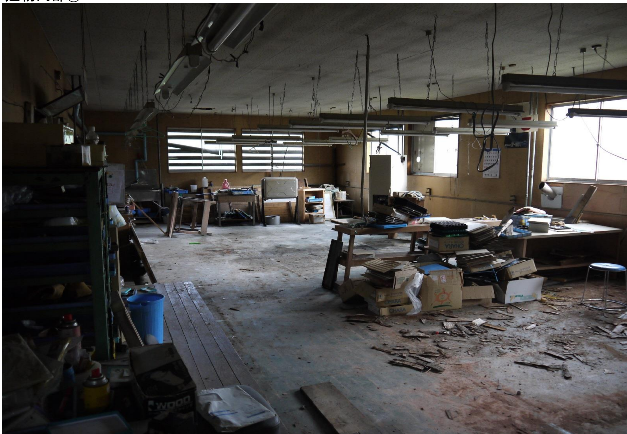
建物内部①
