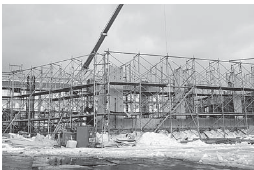
工事が進められる市民プール
