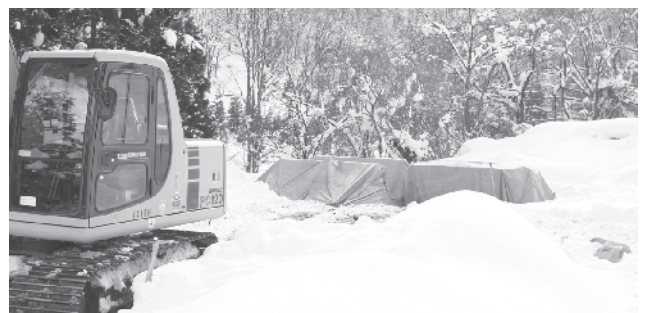
▲ 着工した移動通信鉄塔施設工事
