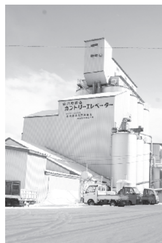
カントリーエレベーター
