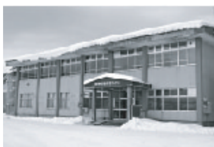
河川改修に伴い解体する前田公民館（前田基幹集落センター）
