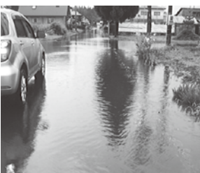
冠水でトイレが逆流
