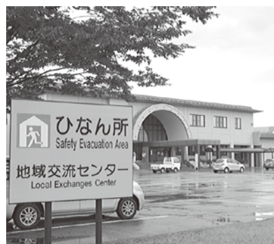
緊急時の停電に備え避難所に発電機を準備
