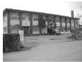
県立3校の校舎は解体の方向
