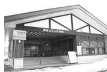
地元住民の活動拠点となるよう検討(森吉山ダム広報館)
