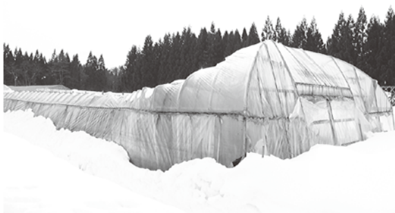
豪雪の影響で倒壊したパイプハウス
