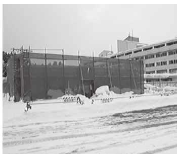
増改修工事が進む 米内沢診療所
