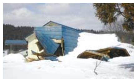
倒壊した、家屋
