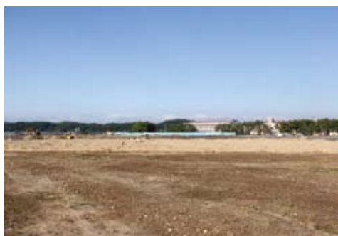
造成工事が進む合川中野球場
