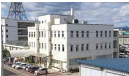
老朽化した中央公民館
