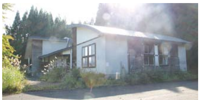
屋根改修される竜森コミセン
