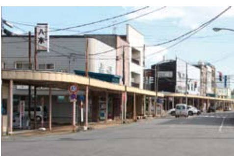
建替え建設されるアーケード
