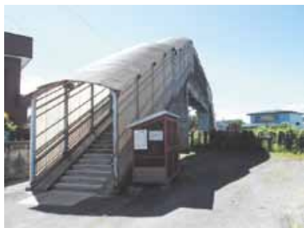
架け替え予定の元町跨線橋
