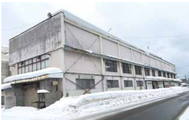
解体予定の合川駅前公民館
