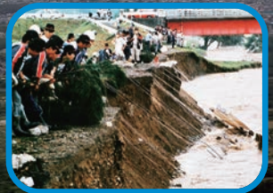
昭和62年8月洪水 (成瀬橋付近での木流し工の様子)
