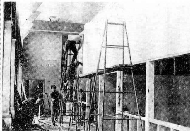
④ 体育館と古河会館では教室造りの突貫工事 12日
