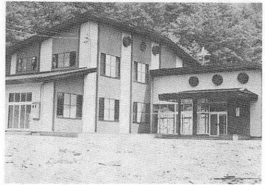
〔真木沢に完成した林業研修センター。レンガ色の建物の内部は、近代的な施設設備となっている。〕
