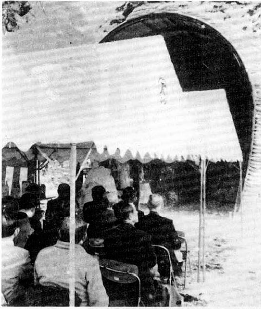
戸鳥内トンネル他工事の安全を願う祈願祭が行われた(小倉のトンネル抗口前で)
