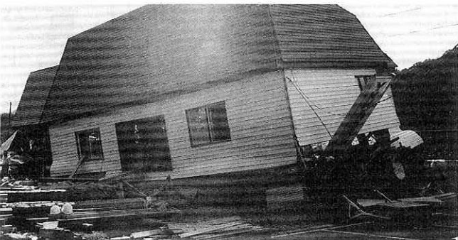
▲ 台風19号の突風で1階部分が完全に押しつぶされてしまった家屋(荒瀬) 非住家も含めると四百三十棟が被害を受けた(平成3年)
