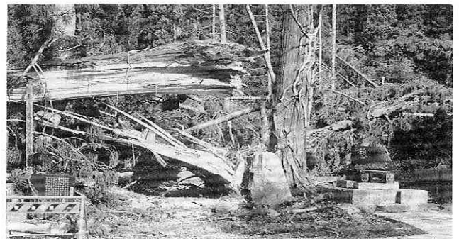
▲ 台風19号でなぎ倒された大木（畑町）
