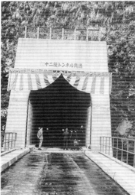
十二段トンネル貫通（昭和53年）
