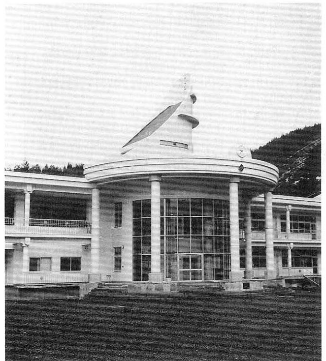
完成した新生大阿仁小学校の校舎
