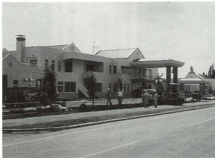
11月1日の入所開始に向けて最後の工事が急ピッチ（9月30日）
